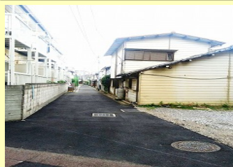
一之江舗装して改善後
